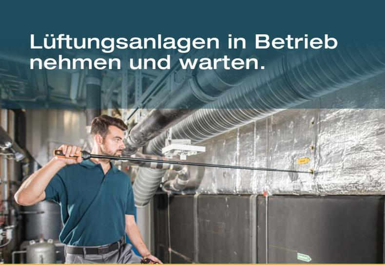
Mit großem und kleinem Flügelrad am Auslass und im Kanal messen
